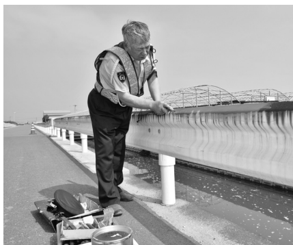
▲ガードレールのさびを落とす武井さん
