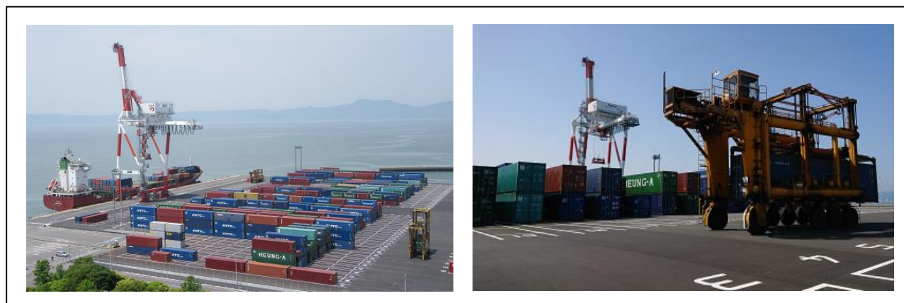
八代港コンテナターミナル
