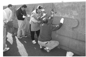
▲日奈久港防波堤の壁画補修
