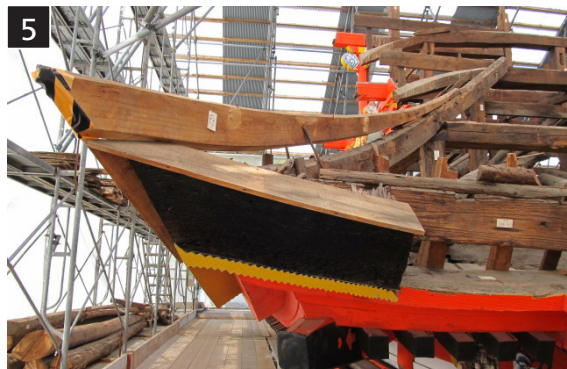
1 銅板と野地板(のじいた)をとりはずすと、屋根裏の部材が見えてきます 2 他の用途の部材が垂木(たるき)として転用されていることが、釘の位置や加工痕から分かります 3 力神像の裏面には「長四郎作之」と、製作にかかわった人名が書かれています 4 垂木の先端を覆う銅板の裏面。享保九年(1724)の文字が記されており、これまでの記録では知られていない修理であることが分かりました 5 屋根の造りと残された檜皮(黒い部分)から、銅板葺になる前は檜皮葺(ひわだぶき)であったことが分かります 6 千鳥破風に飾られた鶴の彫刻。長年の風雨で傷んでいます
