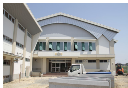
▲完成した体育館と武道場（左）
