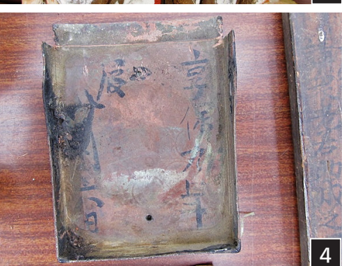
1 銅板と野地板(のじいた)をとりはずすと、屋根裏の部材が見えてきます 2 他の用途の部材が垂木(たるき)として転用されていることが、釘の位置や加工痕から分かります 3 力神像の裏面には「長四郎作之」と、製作にかかわった人名が書かれています 4 垂木の先端を覆う銅板の裏面。享保九年(1724)の文字が記されており、これまでの記録では知られていない修理であることが分かりました 5 屋根の造りと残された檜皮(黒い部分)から、銅板葺になる前は檜皮葺(ひわだぶき)であったことが分かります 6 千鳥破風に飾られた鶴の彫刻。長年の風雨で傷んでいます
