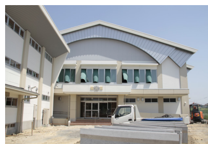
▲完成した体育館と武道場（左）
