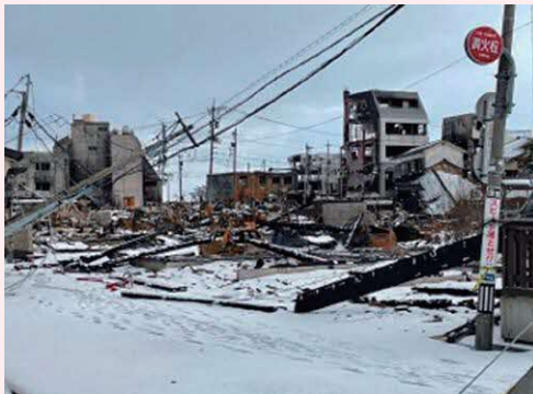
朝市通りの被災状況
