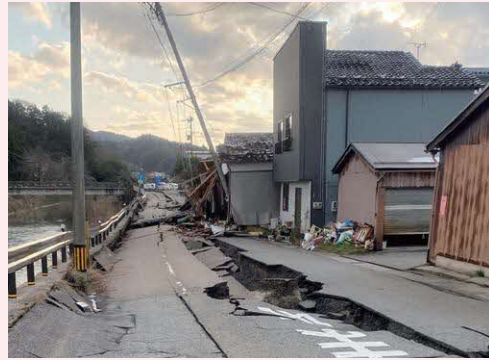
道路の亀裂や隆起などが多数
