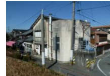
① 徳淵ポンプ場
