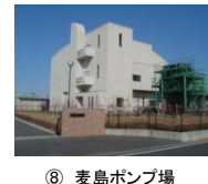
⑧ 麦島ポンプ場
