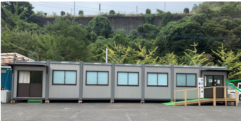
<坂本支所仮設事務所>
