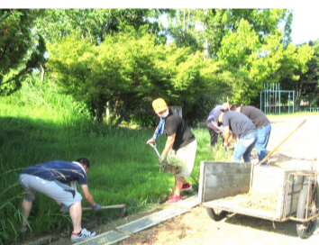
側溝の土を出すPTAの皆さん
