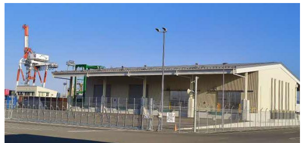
CFS 倉庫の外観 資料：八代市
