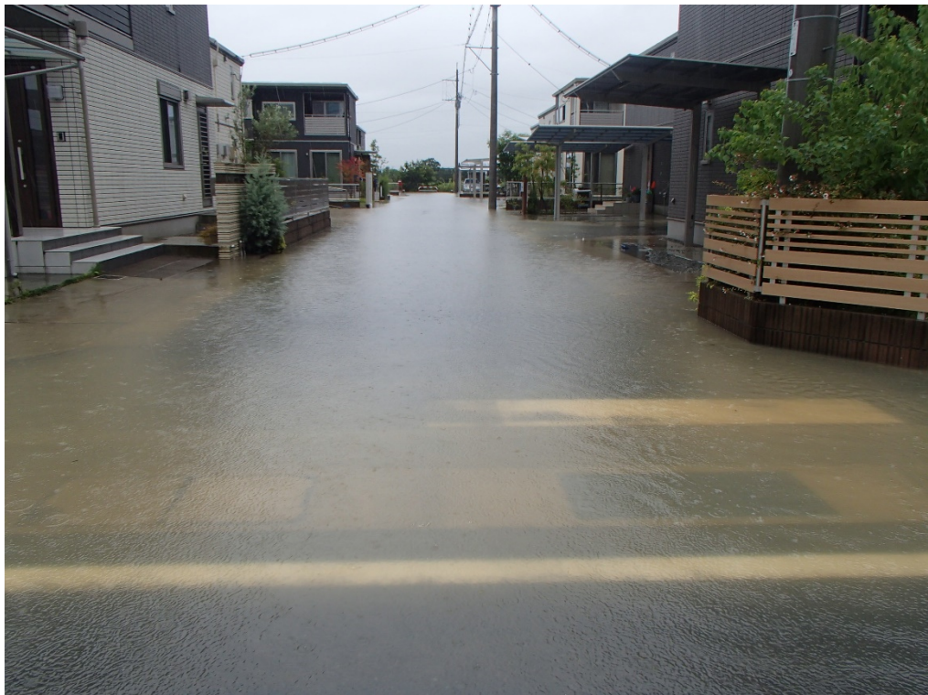
(令和3年8月13日 大雨時の道路冠水の様子)
