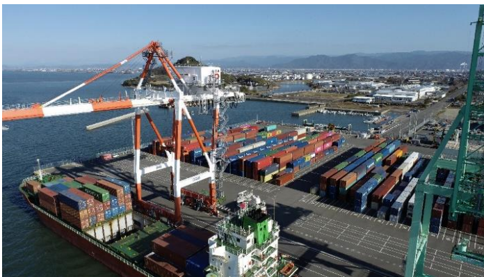
(八代港の大型カントリークレーン・新コンテナターミナル)
