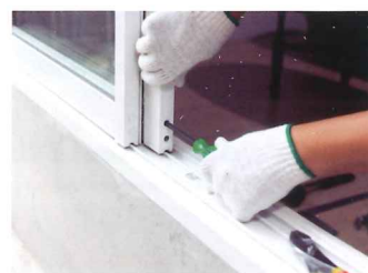
③破損個所の修理
