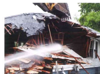
⑥解体全般
