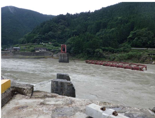
[写真] JR肥薩線橋梁流失
