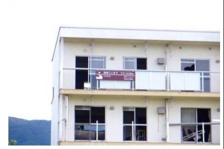
宮城県南三陸町小泉の廃アパート。最上階の4階ベランダには「津波ここまで」の表示板が設置されていた(辛い)。
