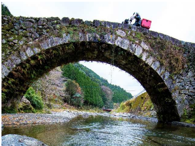
16. 笠松橋(橋上を郵便配達バイクが通る)
