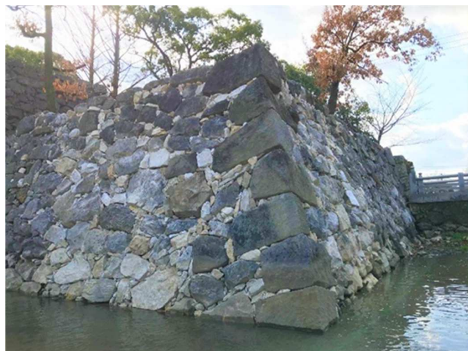
4. 八代城跡 (廊下橋門跡東側石垣)
