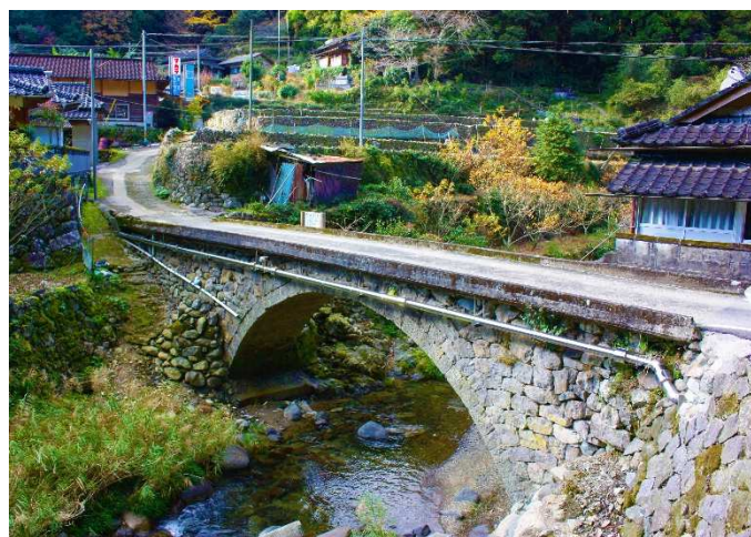
19. めがね橋群(蓼原橋)
