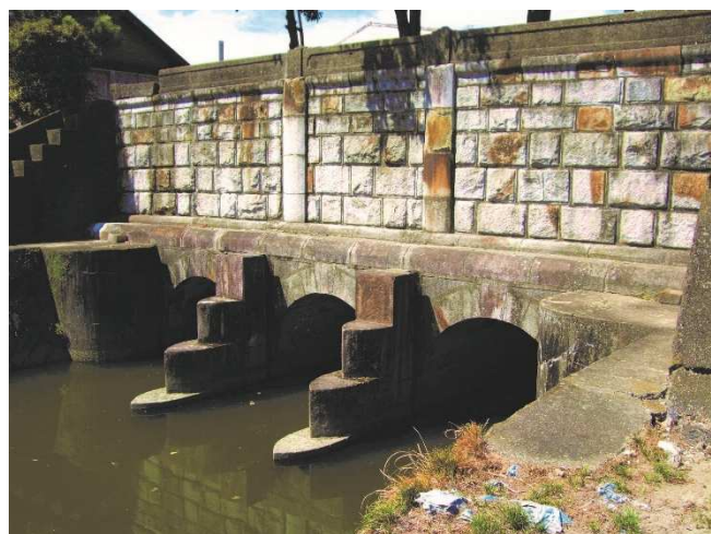
12. 郡築二番町樋門(斜めより撮影)
