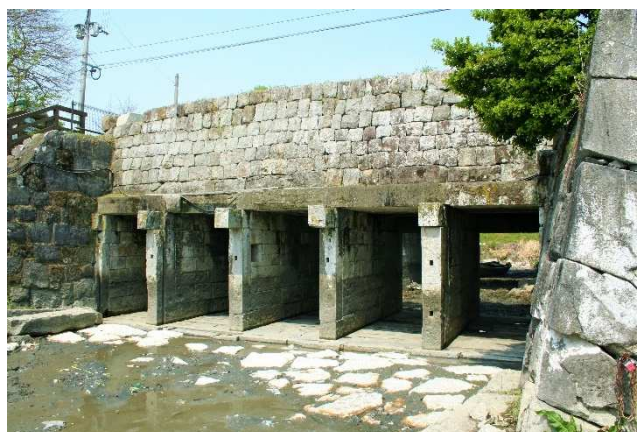
7. 大鞘樋門群(穀樋)
