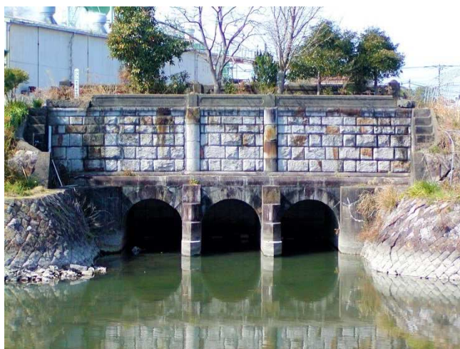
12. 郡築二番町樋門(正面)
