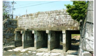
石工たちが築いた「大鞆樋門（穀樋）」
