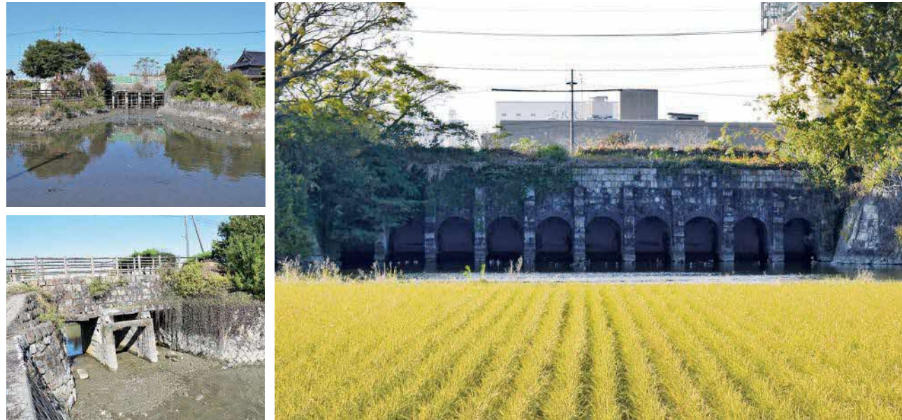
(写真右)旧郡築新地甲号樋門(きゅうぐんちくしんちこうごうひもん)。明治時代に建造された樋門。美しい10連アーチが特徴 (写真左上)大鞘樋門群(おさやひもんぐん)、殻樋(からひ)。1819(文政2)年、鹿子木量平による大規模干拓の際に設けられた (写真左下)大鞘樋門群、二番樋(にばんひ)。通常は城郭に使われるような巨石を加工している ■旧郡築新地甲号樋門 熊本県八代市郡築三番町 ■大鞘樋門群 熊本県八代市鏡町両出/八代市千丁町古閑出
