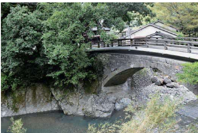
(写真上)石橋の上にコンクリートを重ねているので車も通行できる。道幅は3.55m ■谷川橋 熊本県八代市東陽町河俣鶴中
