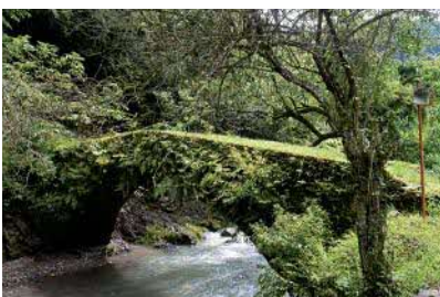
(写真上)石橋の上にコンクリートを重ねているので車も通行できる。道幅は3.55m ■谷川橋 熊本県八代市東陽町河俣鶴中
