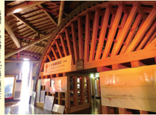
石橋づくりの基礎となる「支保工模型」は博物館のシンボル。
