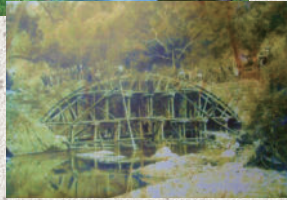
建設中の谷川橋
