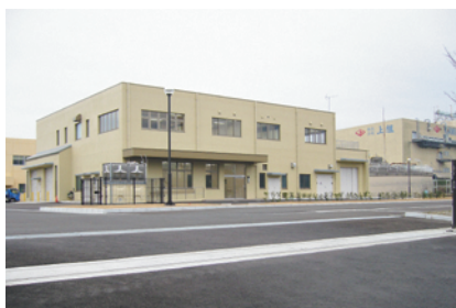
八代市浄化槽汚泥処理施設
