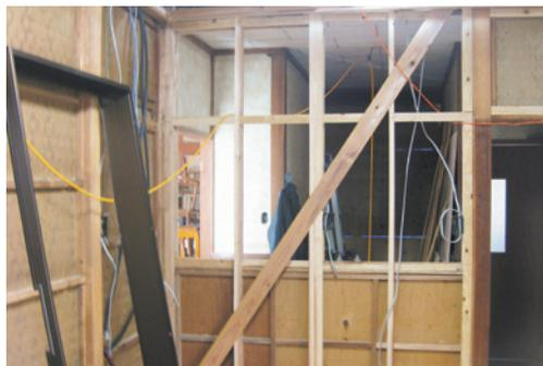
耐震化補強工事の様子
