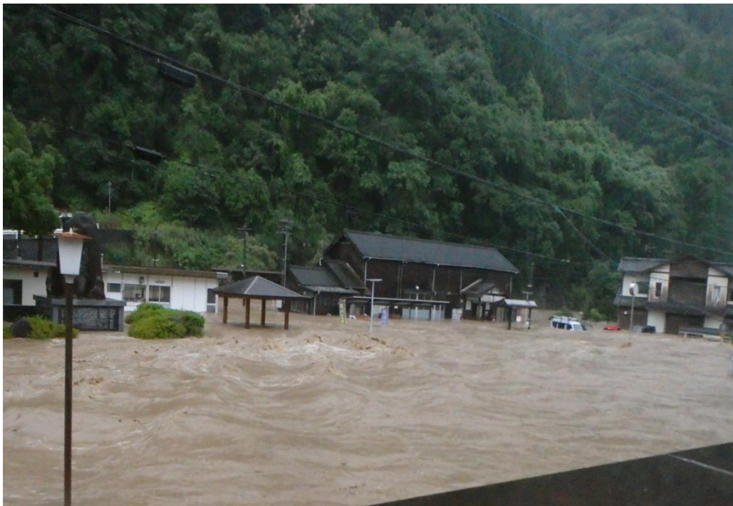
令和2年7月豪雨 JR 肥薩線坂本駅前
