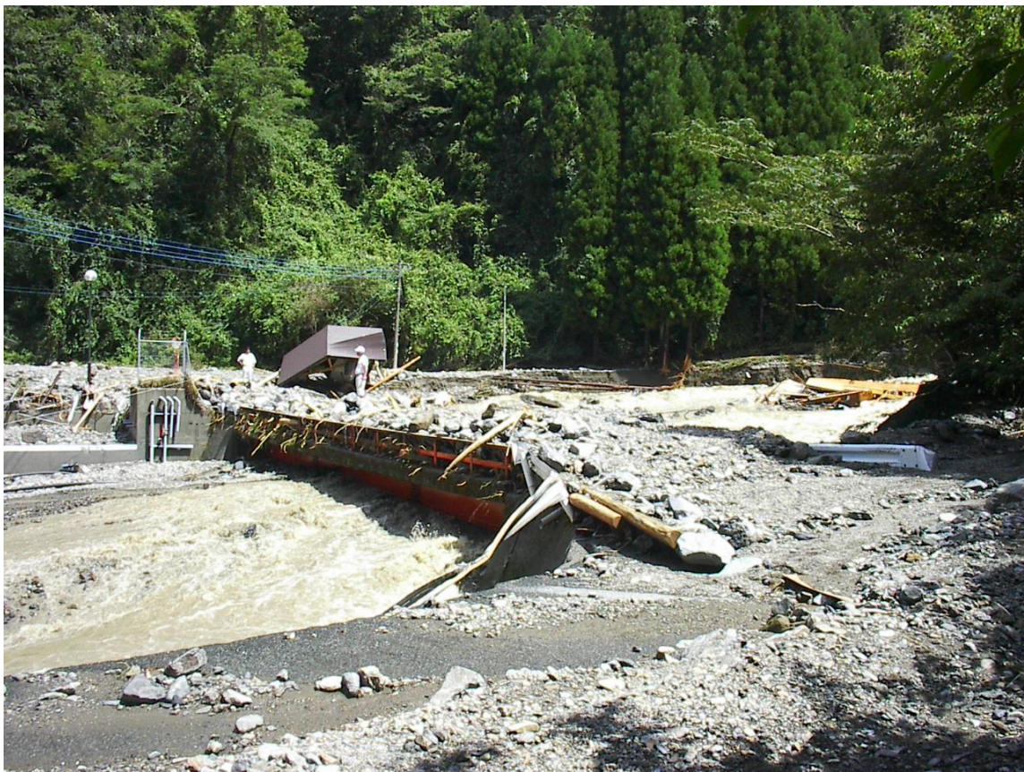
泉町 山ノ津谷川（平成17年 台風14号被災）
