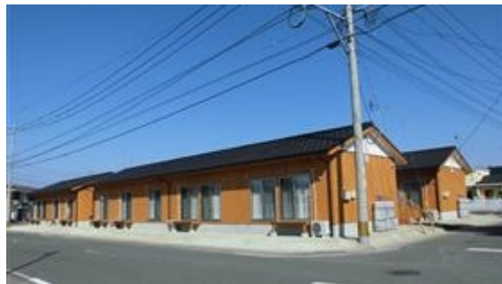
【八代市古閑中町仮設団地】
