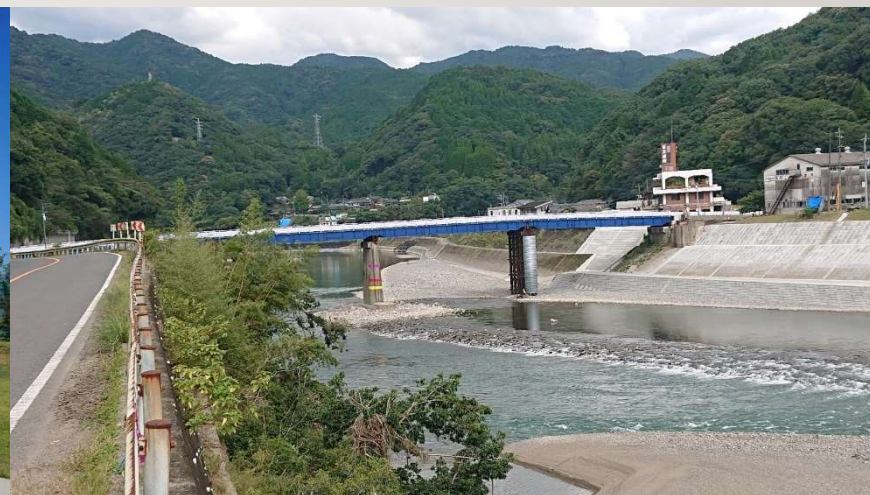
坂本橋の仮橋（国道219号線 左岸上流側より）
