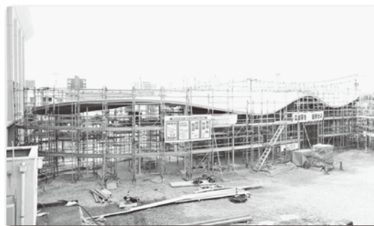
▲事務所棟の屋根が完成しました
