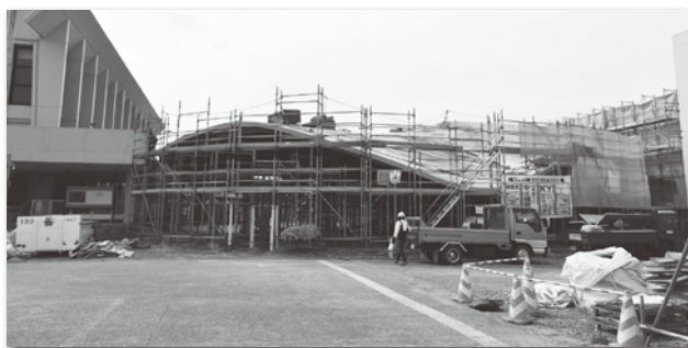
▲外観工事は順調に進んでいます
