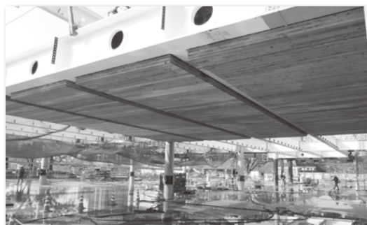
▲CLTの取付工事に着手しています
