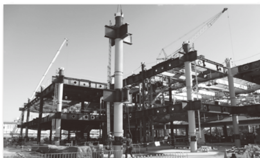
▲鉄骨建方作業が進んでいます
