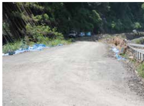
J R肥薩線の線路の上に土を敷き詰めて仮復旧した道路
