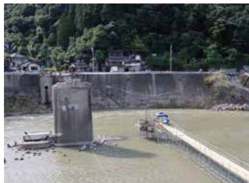
坂本橋の復旧に向けての基礎調査の様子
