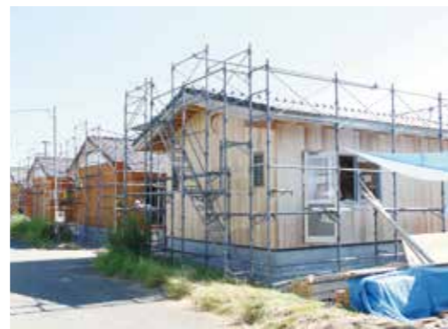
建設が進む八代市市民球場仮設団地
