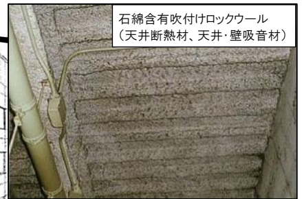
石綿含有吹付けロックウール (鉄骨耐火被覆材)
