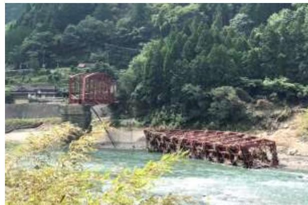
JR肥薩線・球磨川第一橋梁の崩落(8月8日撮影・鎌瀬地区)
