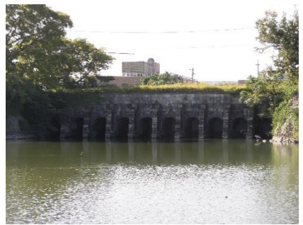
▲旧郡築新地甲号樋門
