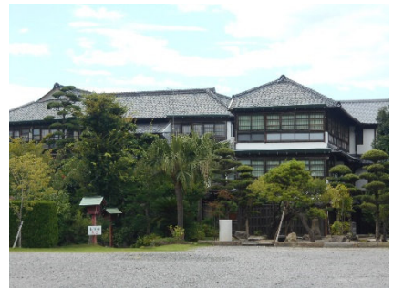
▲日奈久温泉街の木造建造物
