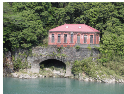
▲深水発電所跡
