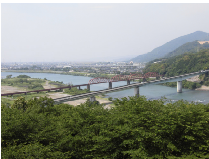
▲球磨川橋梁（奥）と 球磨川大橋（手前）
