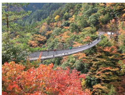
▲梅の木轟公園吊橋
