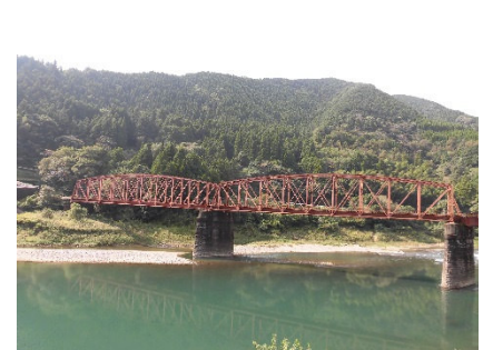
▲球磨川第一橋梁（JR肥薩線）
