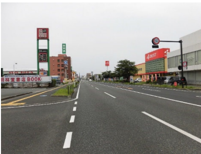
▲国道3号（電線地中化）
