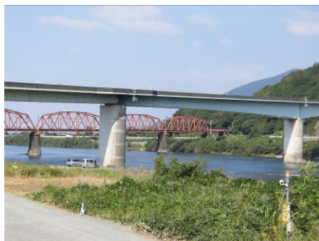
球磨川橋梁（奥）と球磨川大橋（手前）
