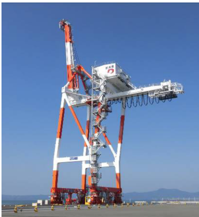
ガントリークレーン
