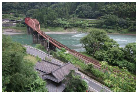
球磨川第一橋梁
