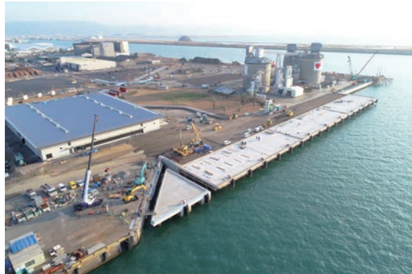
▲着々と工事が進む八代港(1月10日現在) 手前がクルーズ船専用岸壁
