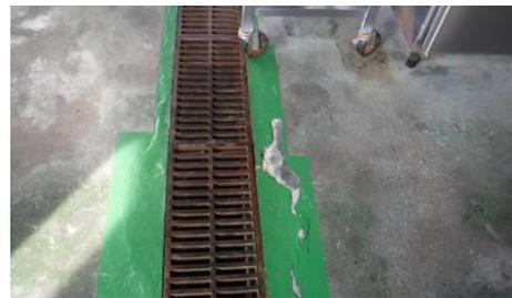
【写真 2-10】塗装の剥がれた床
