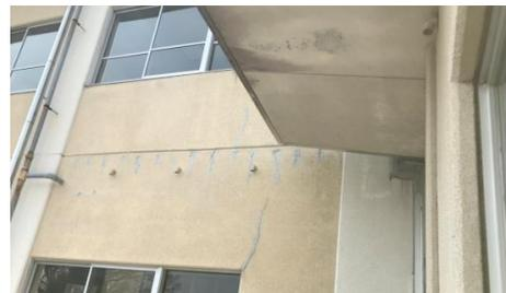
【写真 2-16】ひび割れの発生した外壁
