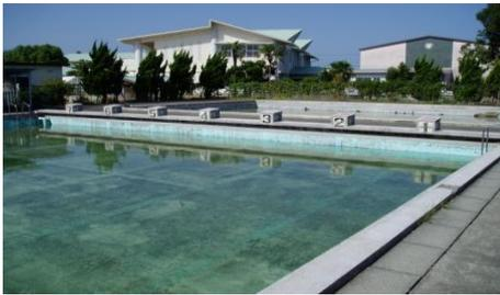
【写真 2-7】塗装の剥がれたプール槽
