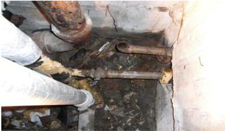
【写真 2-23】破損した給排水管
