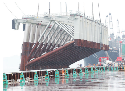
▲海底に据え付けられるジャケット
