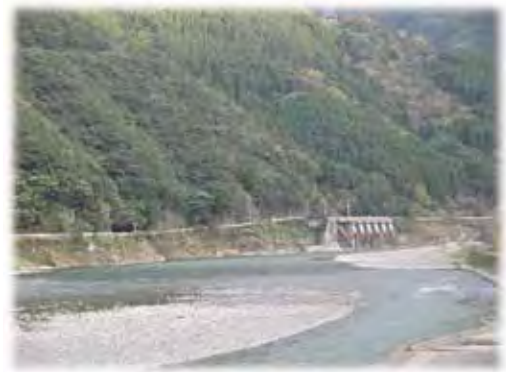
荒瀬ダム撤去後の球磨川
