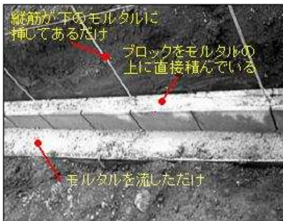
写真4 埋込み基礎の施工例
