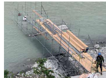
坂本橋の災害対策調査のための足場設置工事の様子
