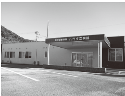
▶平成二十八年十月より 仮設外来棟稼働中
