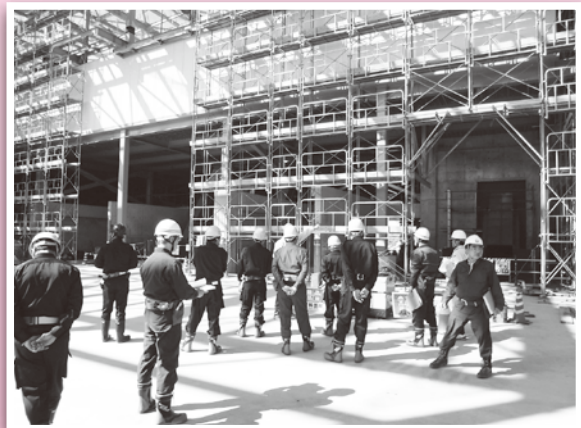
▲ 環境センター建設現場
