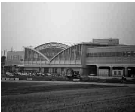
整備が進む新八代駅周辺
