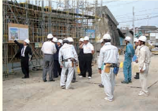
改築中の小学校体育館を視察
