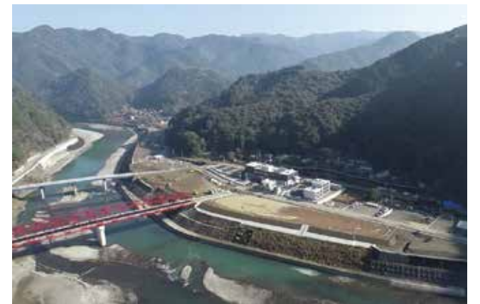
坂本支所 周辺の全景
