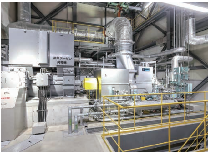
ごみ焼却時の熱で発生する蒸気を利用して発電するエコエイトやつしろの蒸気タービン発電機
