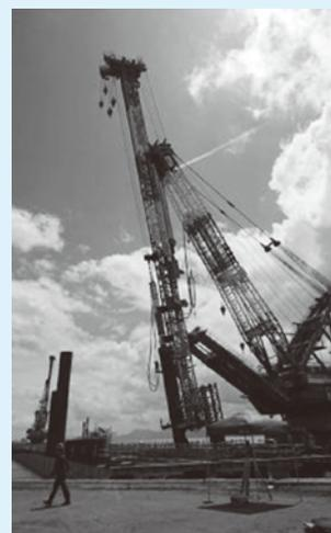
ジャケット式構造岸壁・鋼管杭打設
