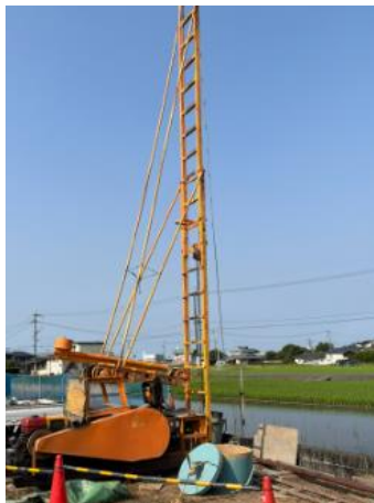
井戸の掘り直し作業の様子
