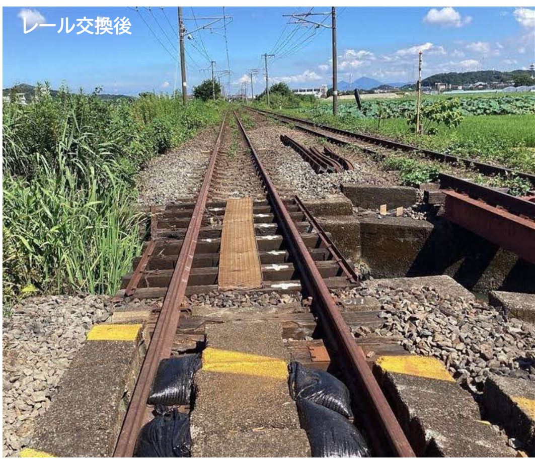
損傷レール交換(松橋・小川間)
