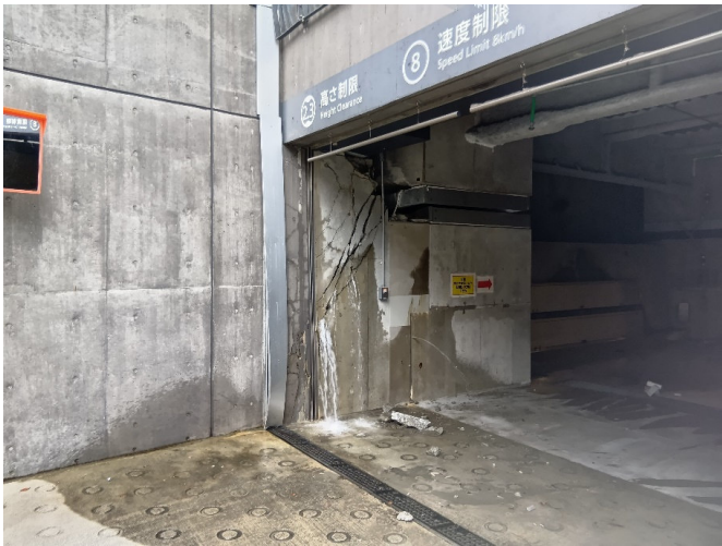
地下駐車場出入口
