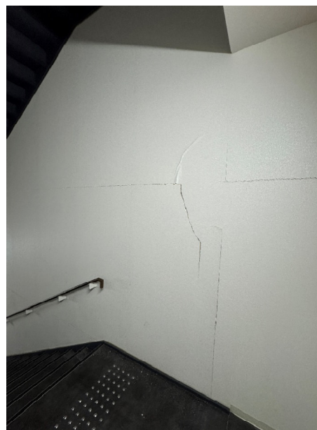
3階西側階段室
