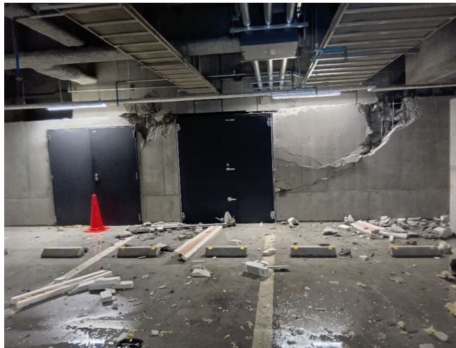
地下駐車場西側壁
