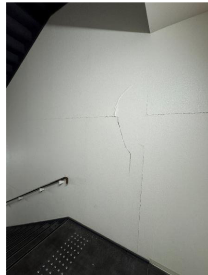
3階西側階段室
