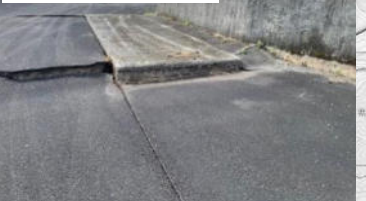
10.新牟田排水機場
