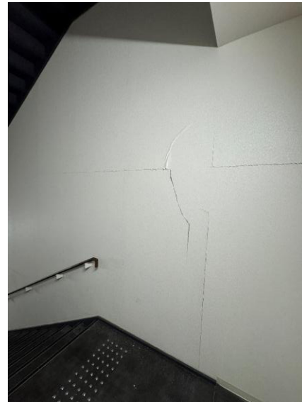
3階西側階段室
