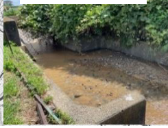
11. 岡町小路農地擁壁
