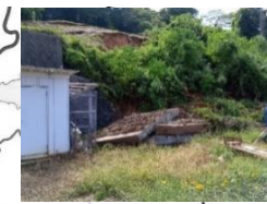
妙見町里道上法面
