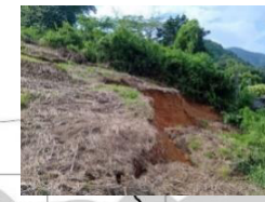
9. 岡町中排水路
