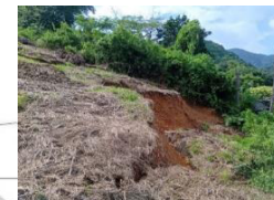
9. 岡町中排水路
