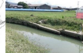
2. 中北町排水路 (旧清掃センター跡地)
