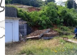
妙見町里道上法面
