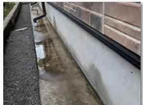
写真⑥ 雨が降っていないのに水がにじみ出ている
