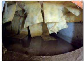
写真③ 床下の断熱材が水を含んではがれ落ちている
