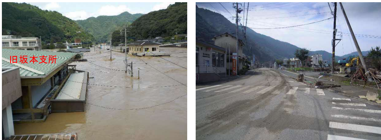
図 1-1 豪雨による浸水状況（左）・被災後の状況（右）
